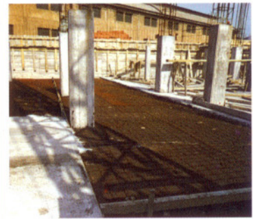
Mallazo de obra
